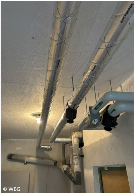
Erneuerung Kaltwasserleitung Humboldtstraße 60-78
