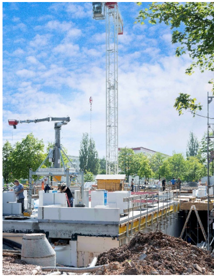
Neubau „Schortehof“ Johann-Friedrich- Boettger-Straße 1a bis d, Ilmenau
